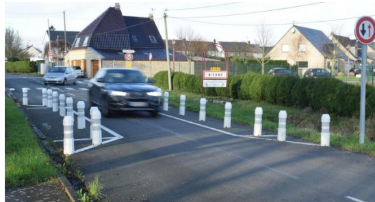
Image 1 – Écluse de voirie
